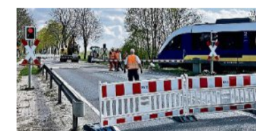
Der Bahnübergang wird zurzeit saniert. Foto: Schmidt
