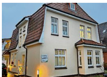
Das Untergeschoss der Praxis wurde nach dem Wasserschaden saniert.
