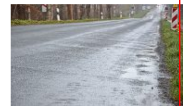
Die Straße „Am Kirchendam“ wird erst in den Osterferien weiter saniert. Bis dahin müssen sich die Autofahrer mit dem derzeitigen Zustand begnügen. Foto: Pape
